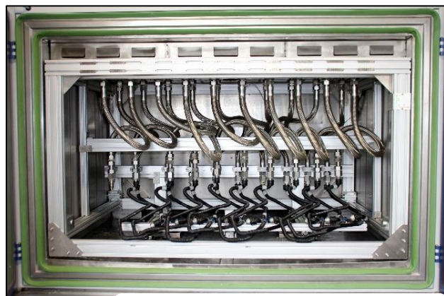
Aufbau in der Prüfkammer
